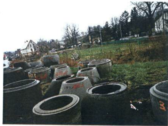
8 Okolice rzeki bez zabezpieczeń (obecnie kręgi zostały usunięte)
