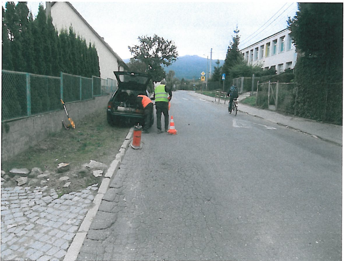
Fot . 10. Lokalizacja odkrywki Nr 6 w km 1+375, pas lewy
