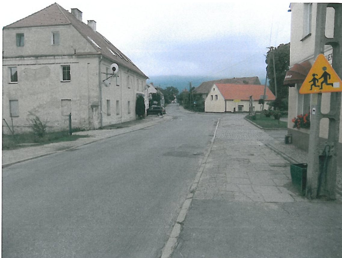
Fot . 13. Widok odcinka ul. R. Zmorskiego, km 1+200.
