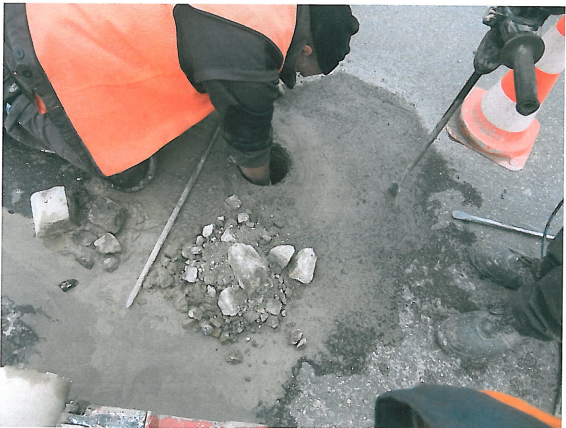
Fot . 12. Pobieranie próbki kruszywa z odkrywki Nr 4 w km 0+875
