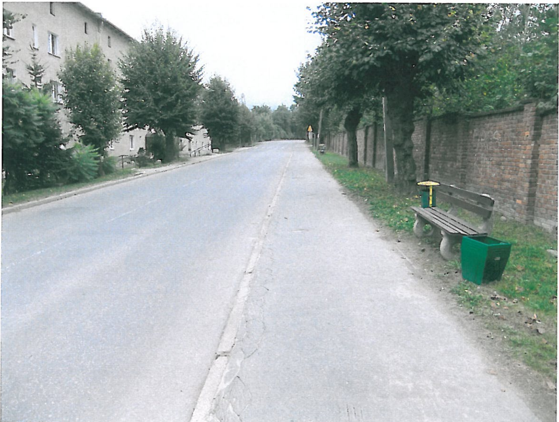
Fot . 10. Widok odcinka ul. R. Zmorskiego, km 0+900.
