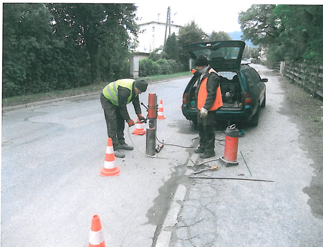
Fot . 10. Lokalizacja odkrywki Nr 3 w km 0+655, pas prawy
