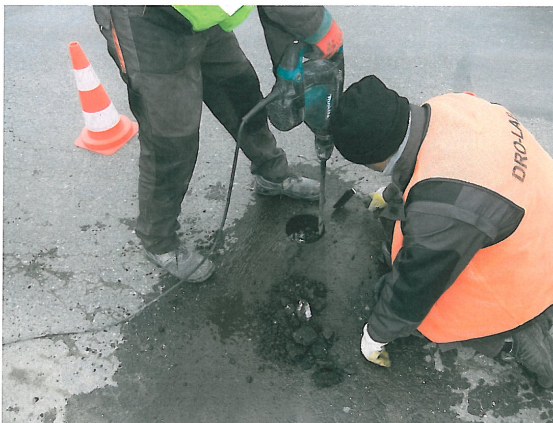
Fot . 12. Pobieranie próbki kruszywa z podbudowy, odkrywki Nr 2 w km 0+375
