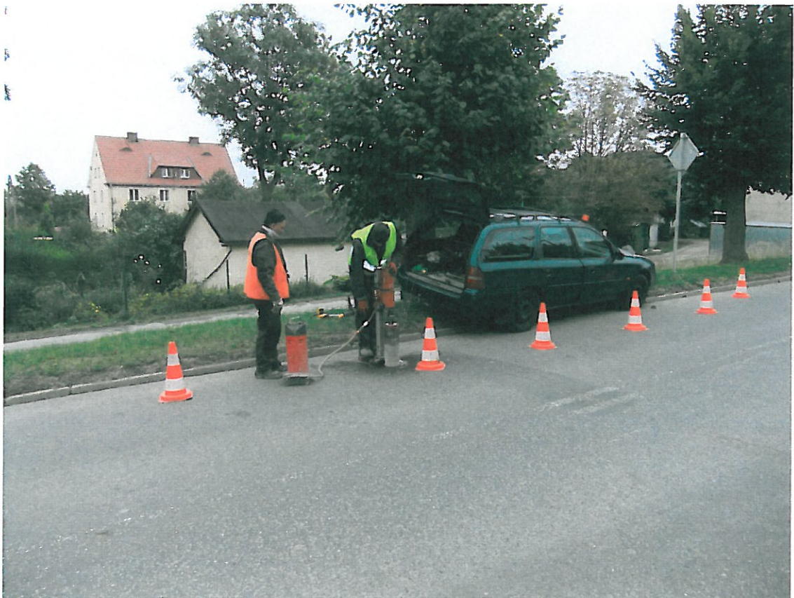
Fot . 10. Lokalizacja odkrywki Nr 4 w km 0+875, pas lewy
