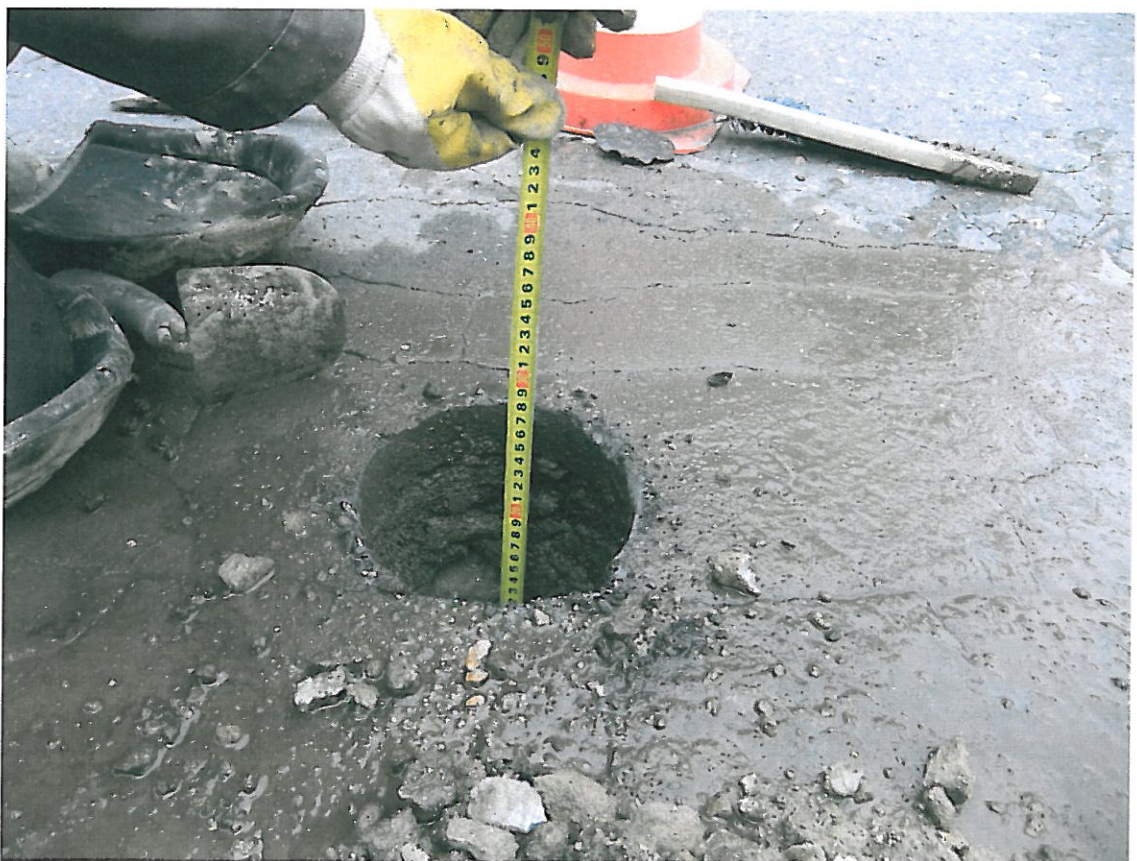
Fot . 13. Pomiar grubości warstw nawierzchni odkrywki Nr 6 w km 1+375.
