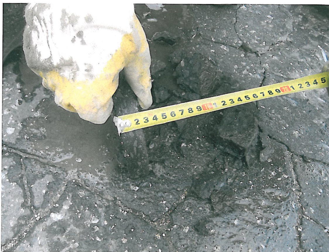
Fot . 12. Widok odwiertu warstw bitumicznych odkrywki Nr 8 w km 1+875
