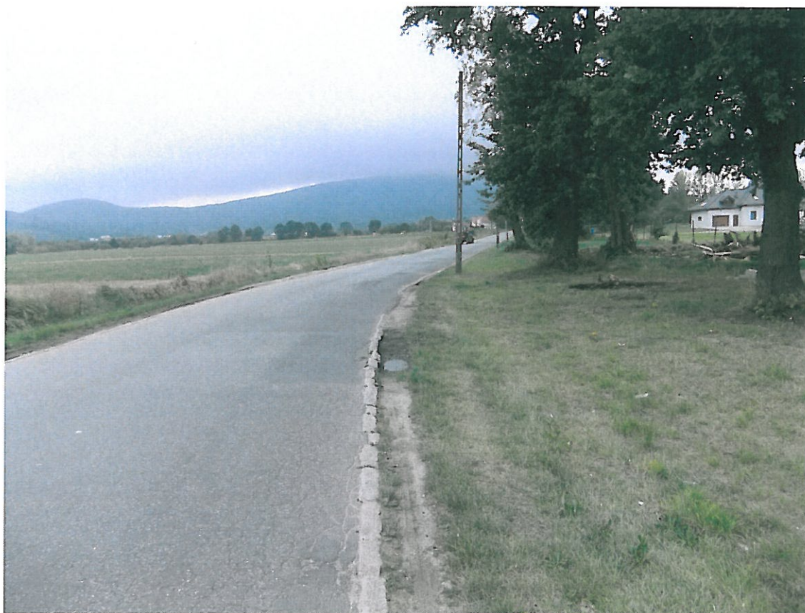
Fot . 10. Lokalizacja odkrywki Nr 1 w km 0+125, pas prawy
