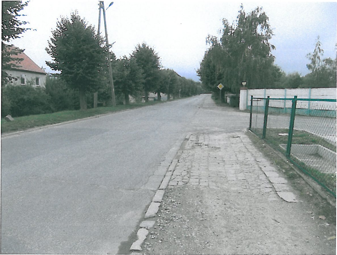
Fot . 9. Widok odcinka ul. R. Zmorskiego, km 0+800.
