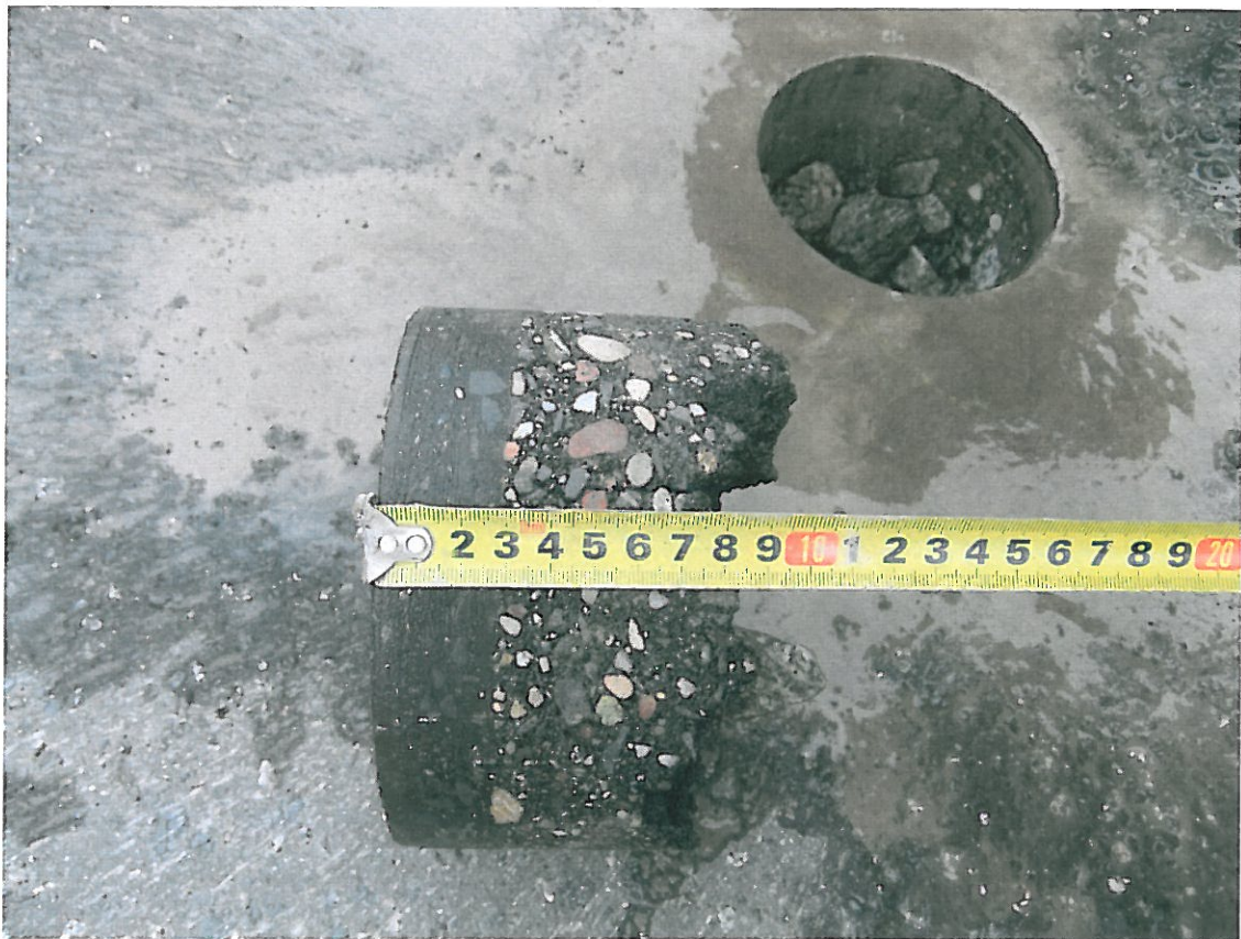
Fot . 12. Widok odwiertu warstw bitumicznych odkrywki Nr 7 w km 1+625
