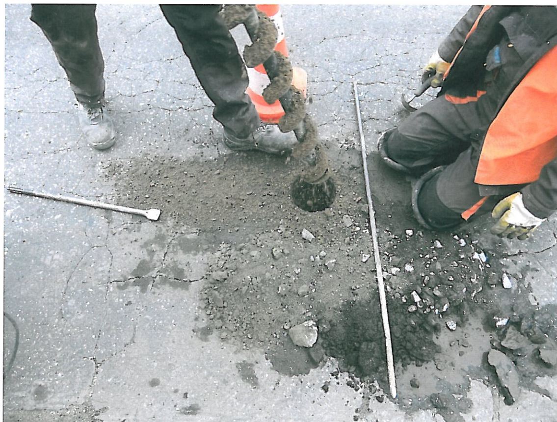
Fot . 13. Pobieranie próbki z podłoża odkrywki Nr 8 w km 1+875.
