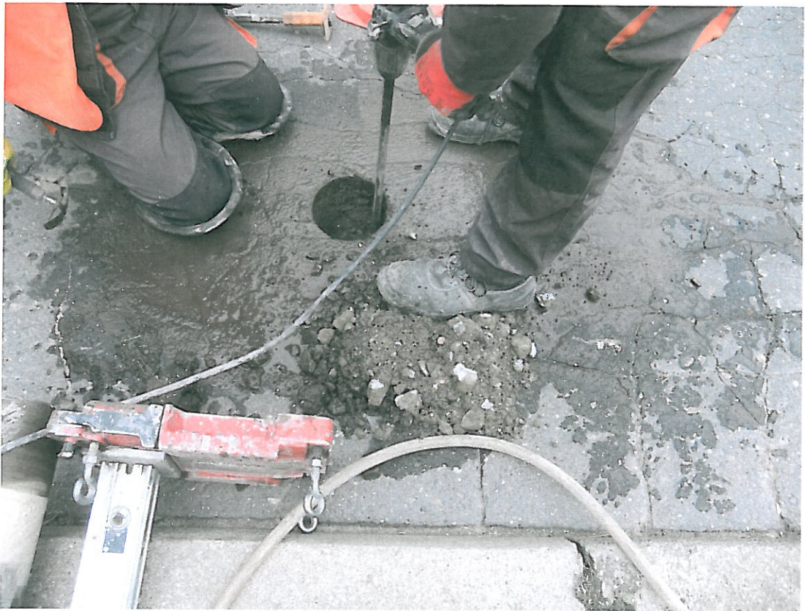
Fot . 12. Pobieranie próbki kruszywa z podbudowy, odkrywki Nr 6 w km 1+375
