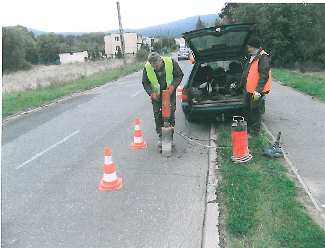
Fot . 10. Lokalizacja odkrywki Nr 7 w km 1+625, pas prawy
