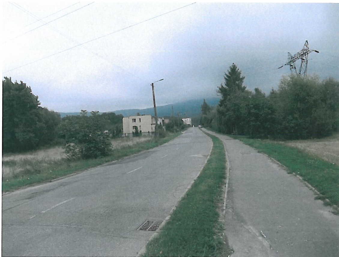
Fot . 17. Widok odcinka ul. M. C. Skłodowskiej, km 1+600.
