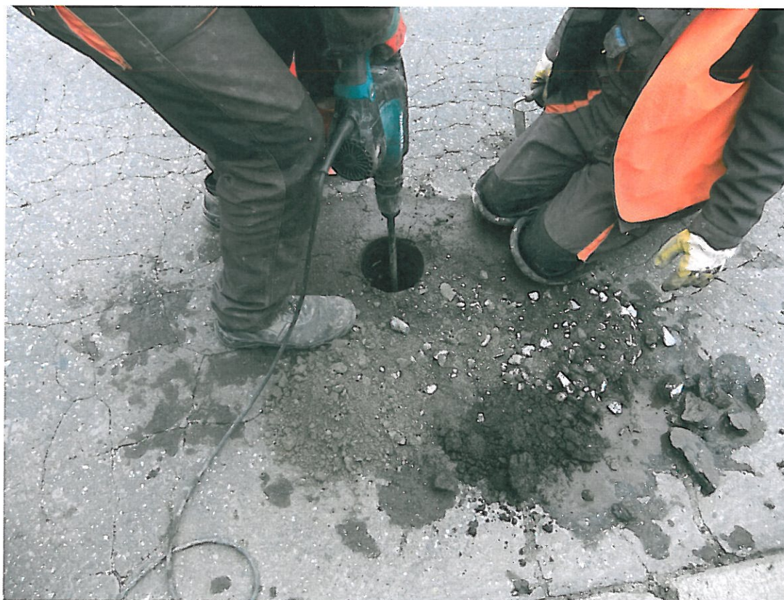
Fot . 12. Pobieranie próbki kruszywa z podbudowy, odkrywki Nr 8 w km 1+875
