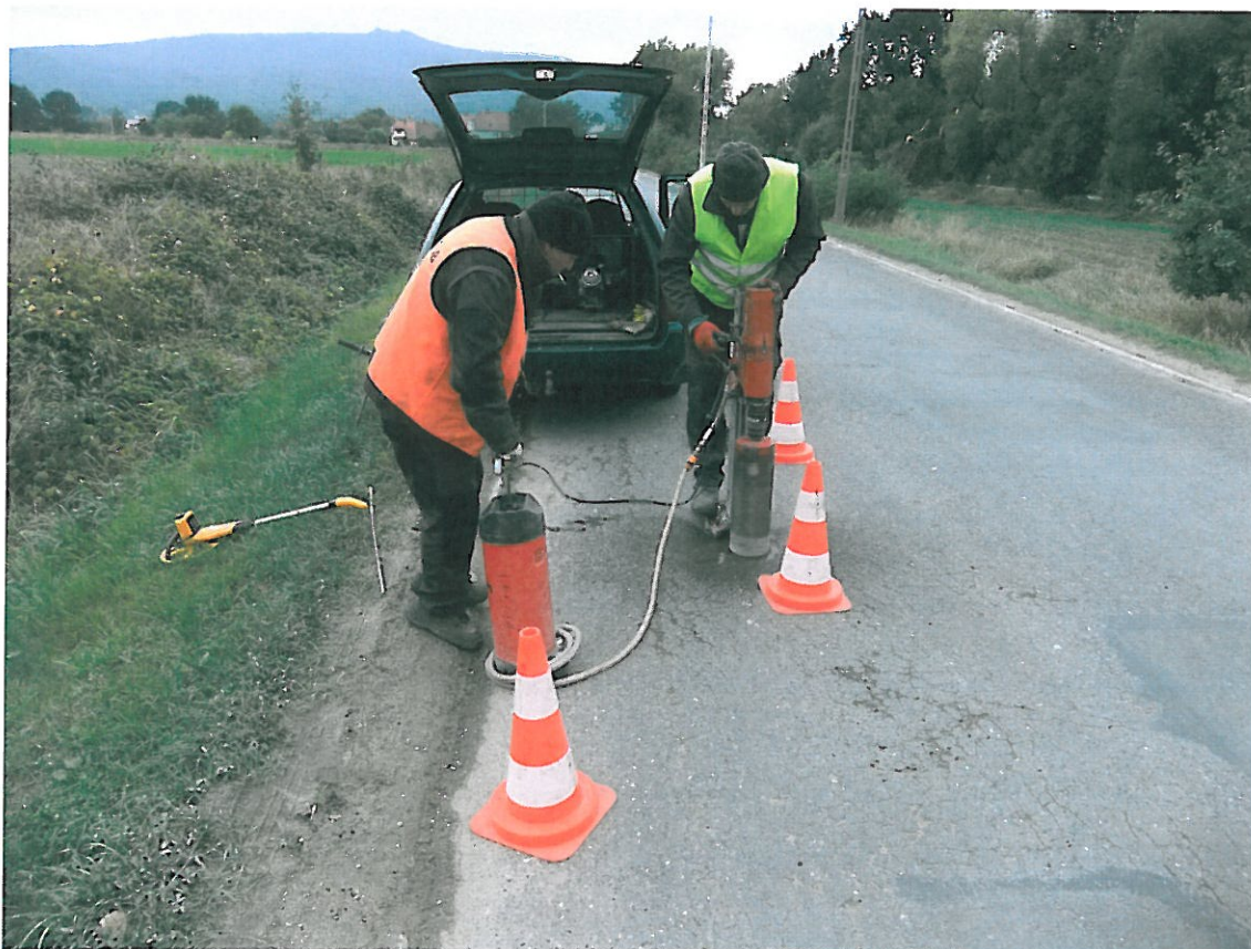
Fot . 10. Lokalizacja odkrywki Nr 2 w km 0+375, pas lewy
