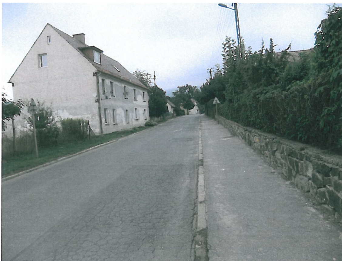
Fot . 14. Widok odcinka ul. M. C. Skłodowskiej, km 1+300.
