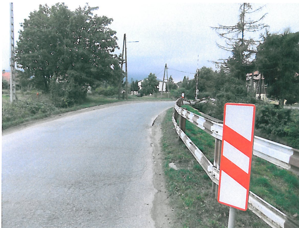
Fot . 6. Widok odcinka ul. R. Zmorskiego, km 0+500.
