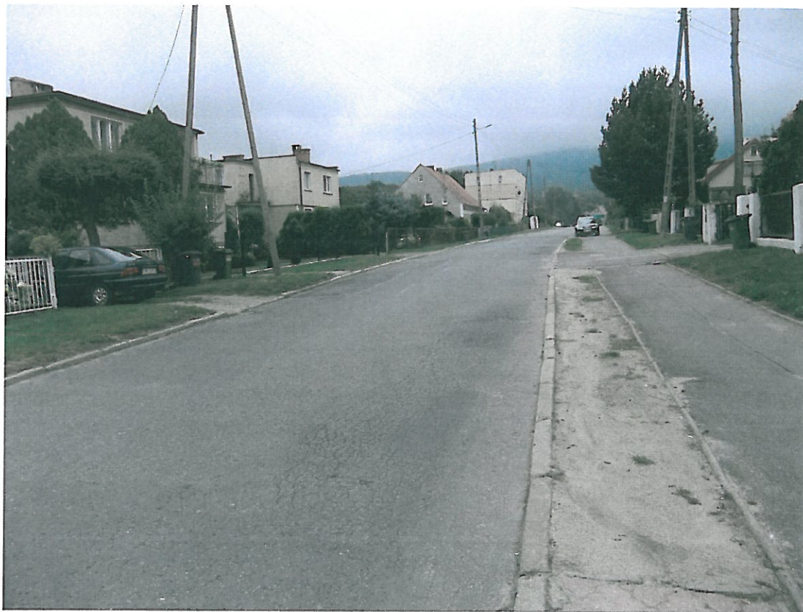
Fot . 19. Widok odcinka ul. M. C. Skłodowskiej, km 1+800.
