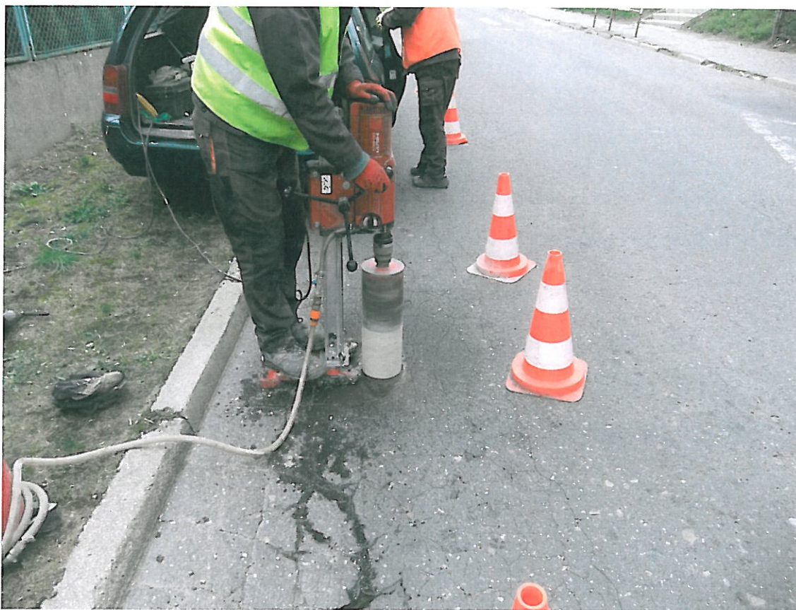
Fot . 12. Pobieranie próbki warstw bitumicznych, odkrywki Nr 6 w km 1+375
