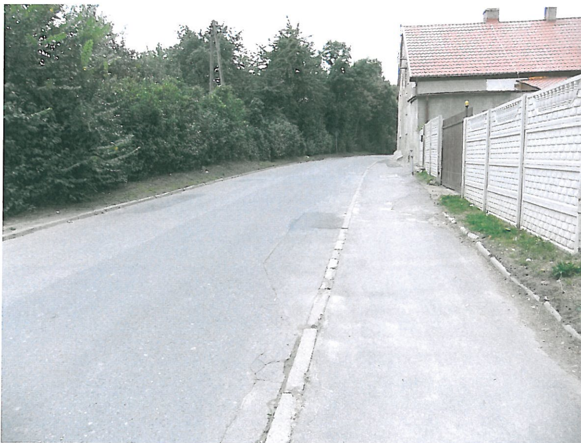
Fot . 11. Widok odcinka ul. R. Zmorskiego, km 1+000.
