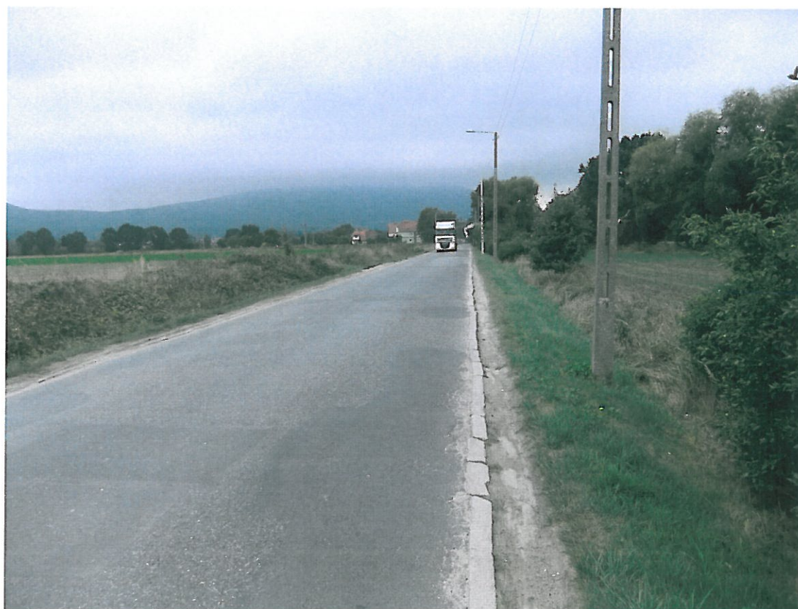
Fot . 4. Widok odcinka ul. R. Zmorskiego, km 0+300.
