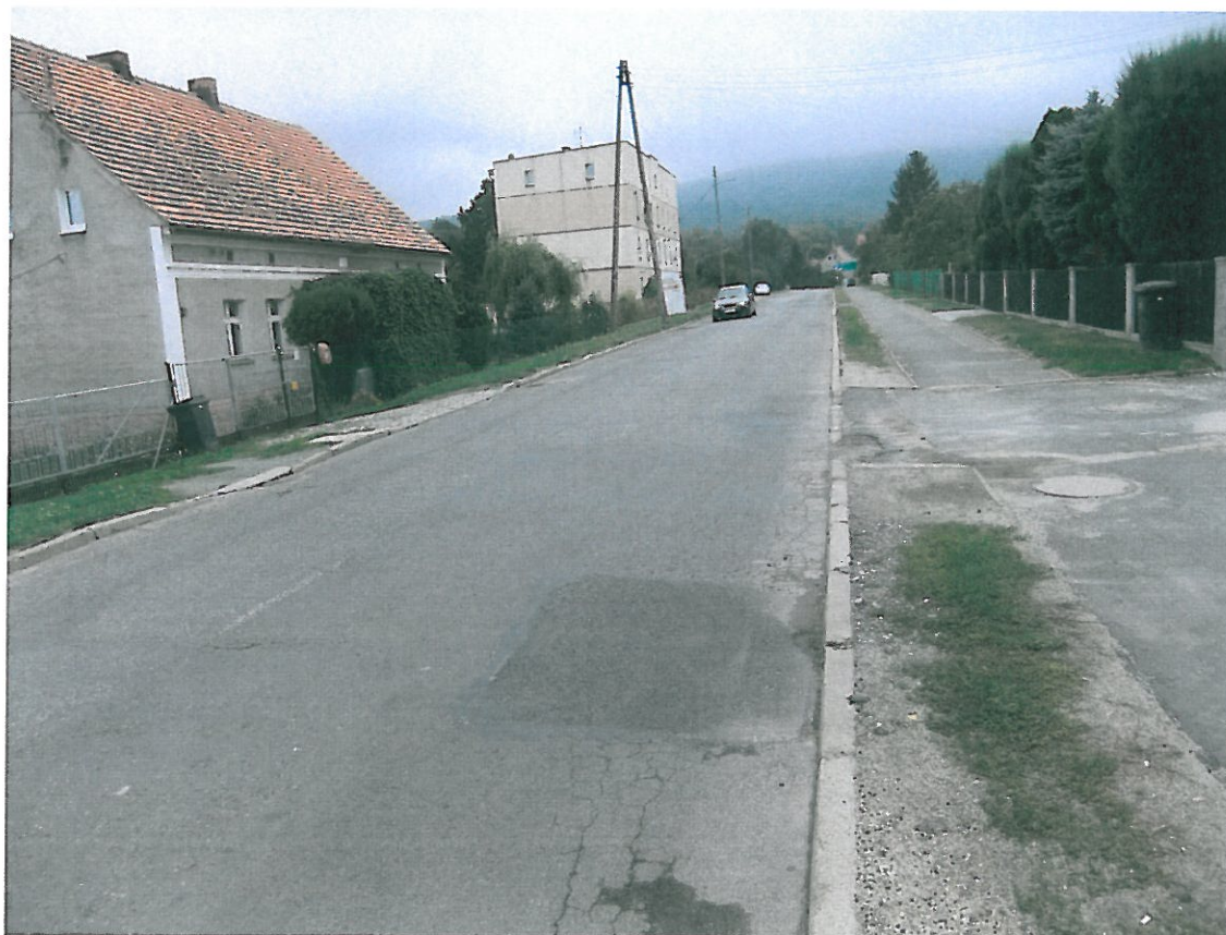
Fot . 20. Widok odcinka ul. M. C. Skłodowskiej, km 1+900.
