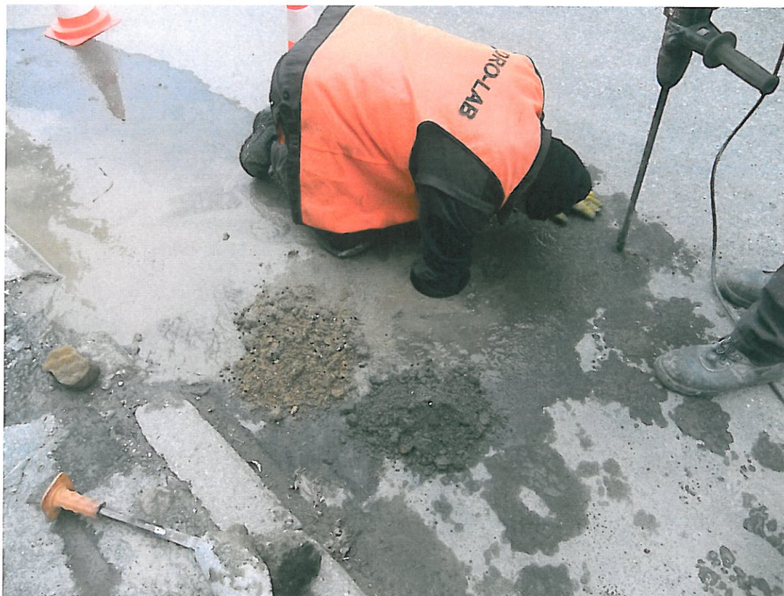
Fot . 13. Widok odkrywki Nr 3 w km 0+655, pobieranie próbki pospółki.
