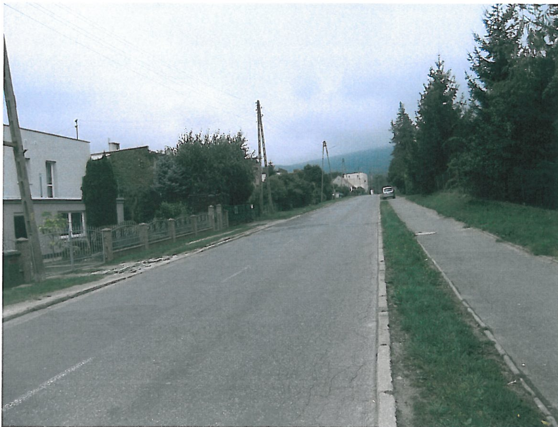
Fot . 18. Widok odcinka ul. M. C. Skłodowskiej, km 1+700.
