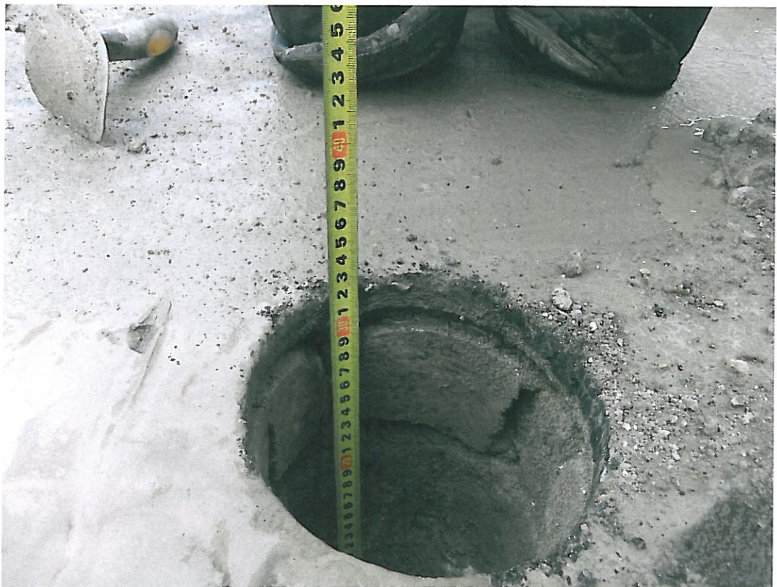
Fot . 13. Pomiar grubości warstw nawierzchni odkrywki Nr 4 w km 0+875.
