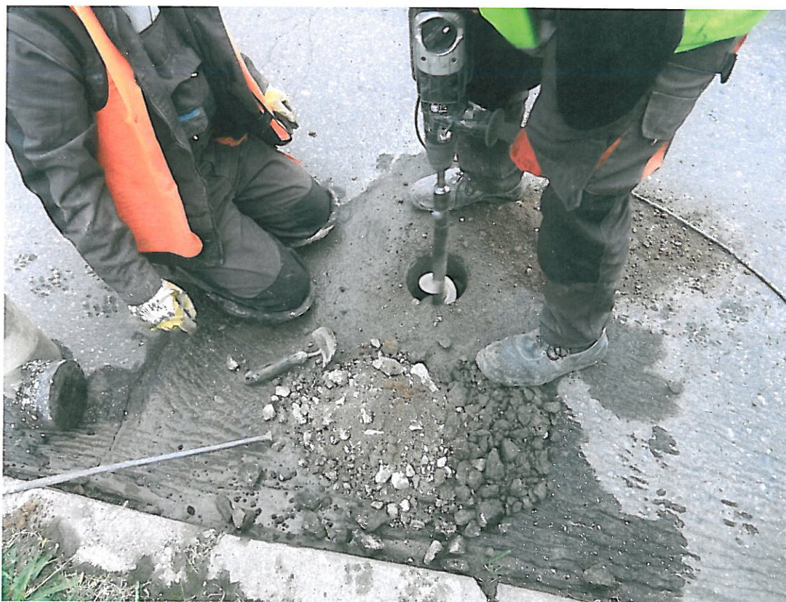
Fot . 13. Pobieranie próbki z podłoża odkrywki Nr 7 w km 1+625.
