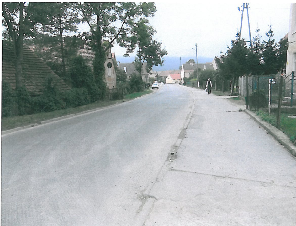
Fot . 12. Widok odcinka ul. R. Zmorskiego, km 1+100.
