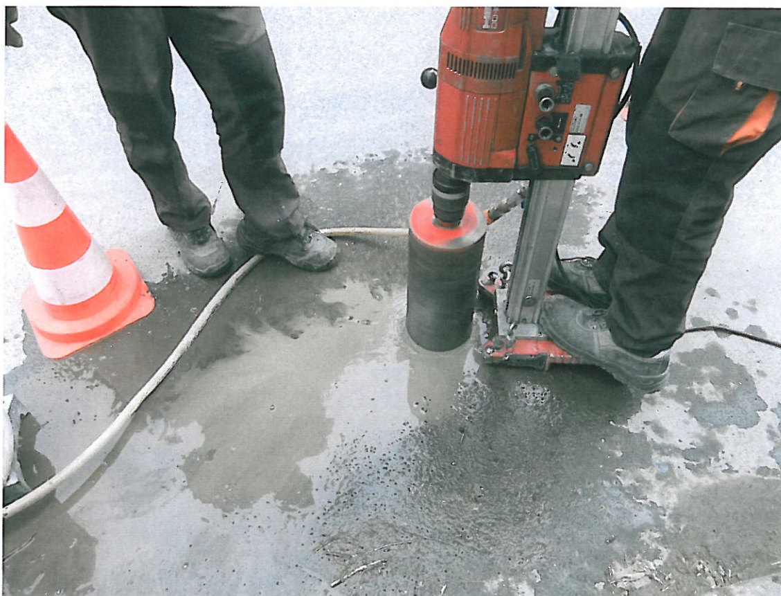
Fot . 11. Pobieranie próbki z podbudowy odwiertu Nr 3 w km 0+655, pas prawy
