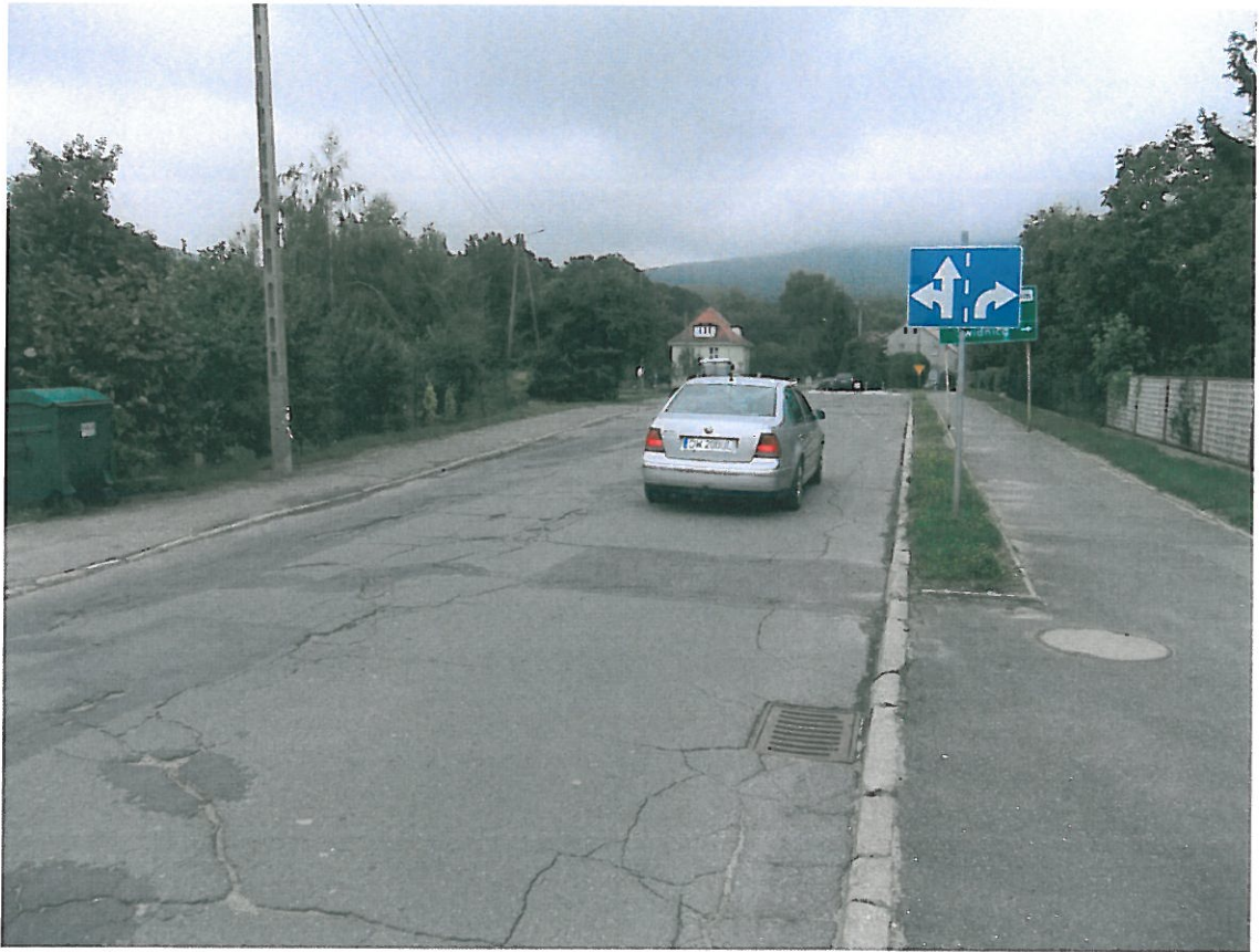
Fot . 21. Widok odcinka ul. M. C. Skłodowskiej, km 2+000.
