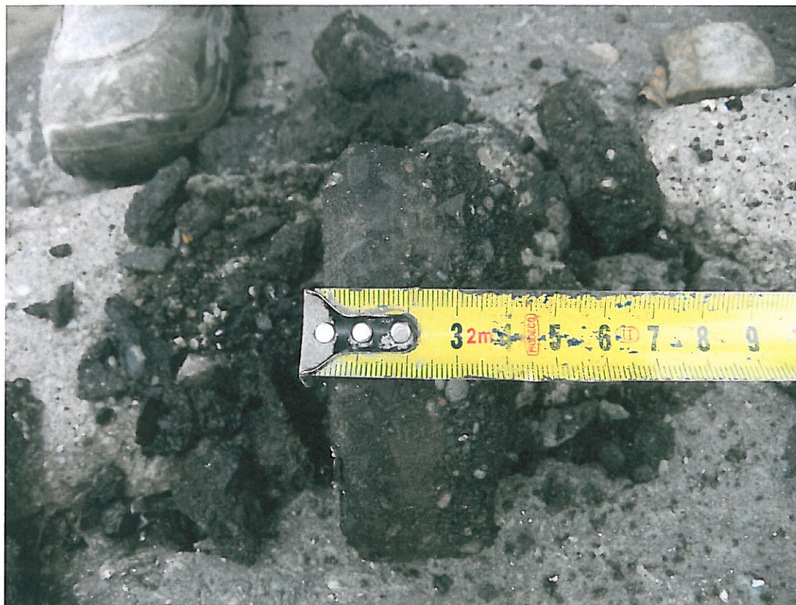
Fot . 12. Pomiar grubości warstw bitumicznych z odkrywki Nr 5 w km 1+105
