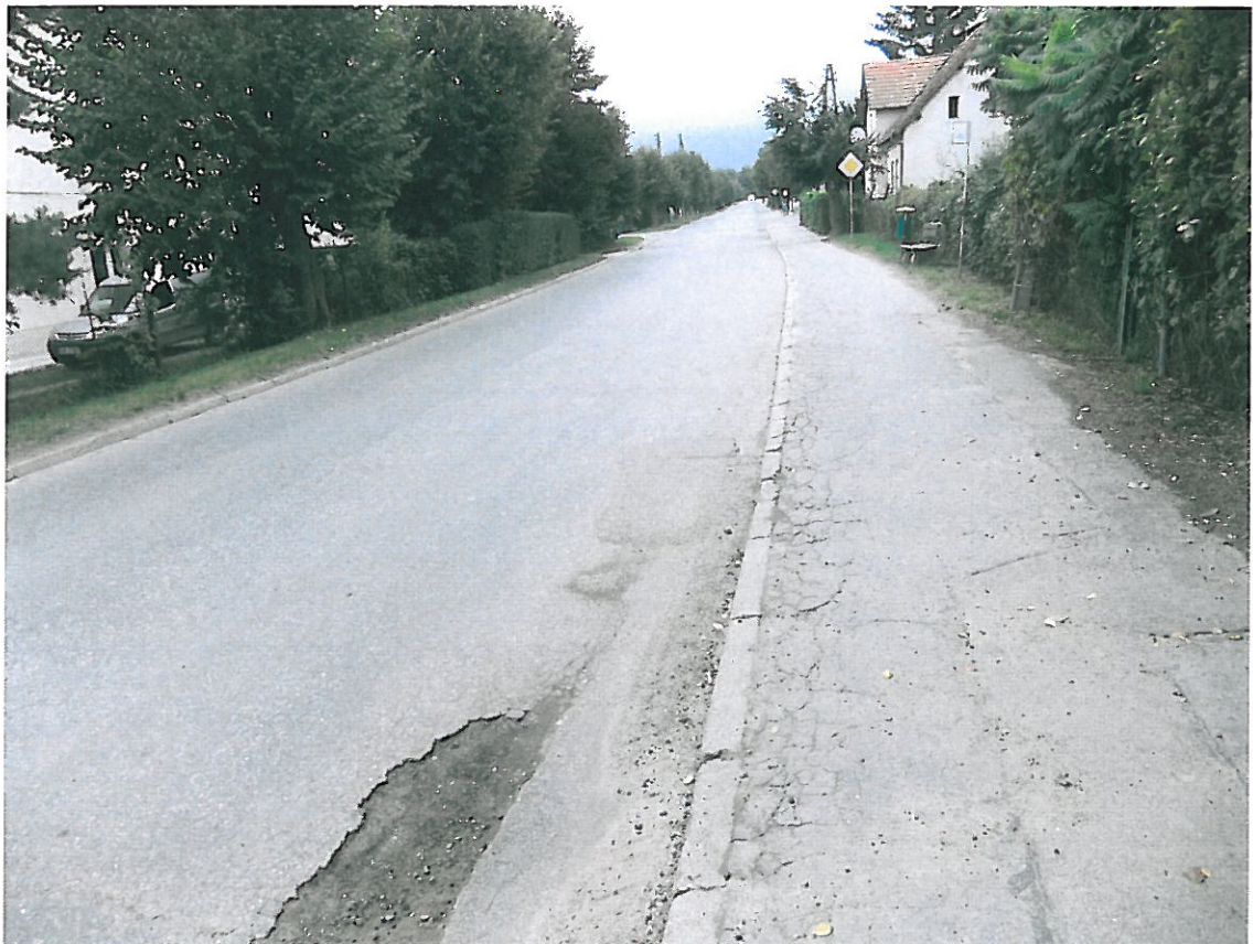
Fot . 8. Widok odcinka ul. R. Zmorskiego, km 0+700.
