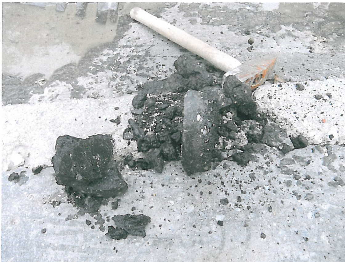
Fot . 12. Widok odwiertu warstw bitumicznych z odkrywki Nr 5 w km 1+105
