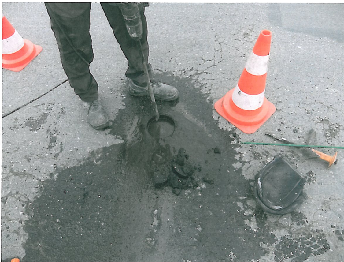
Fot . 12. Widok odwiertu warstw bitumicznych odkrywki Nr 2 w km 0+375
