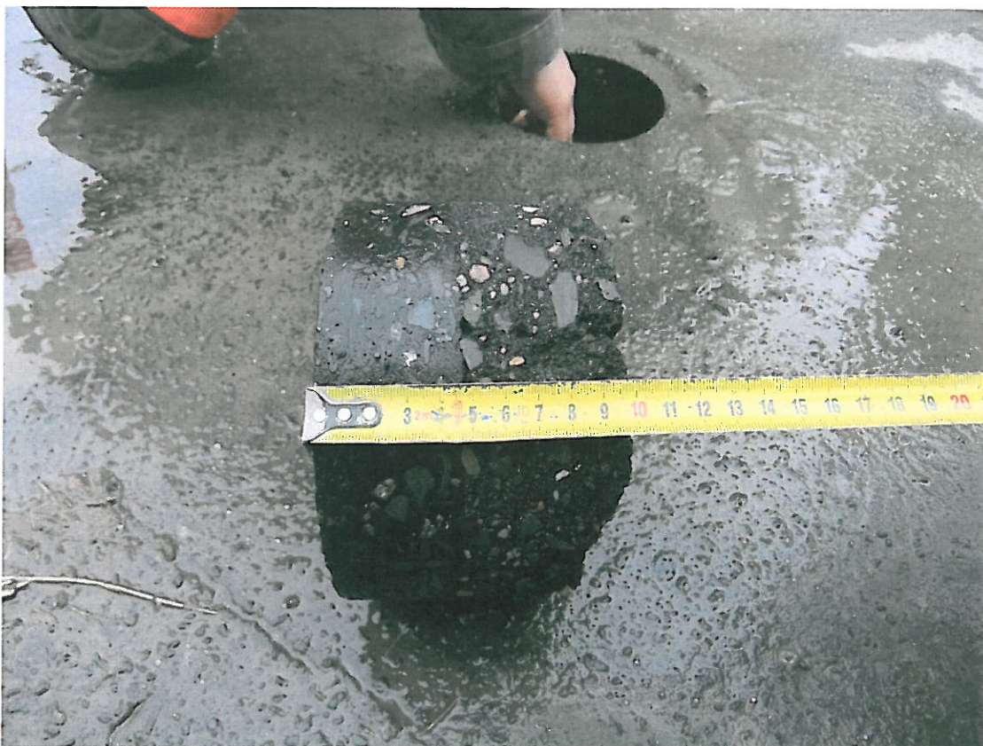
Fot . 12. Widok odwiertu warstw bitumicznych odkrywki Nr 3 w km 0+655
