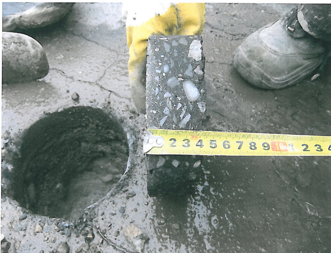
Fot . 12. Widok odwiertu warstw bitumicznych odkrywki Nr 6 w km 1+375
