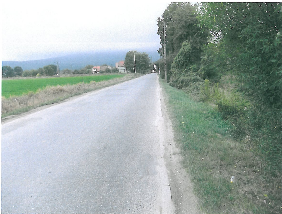
Fot . 5. Widok odcinka ul. R. Zmorskiego, km 0+400.
