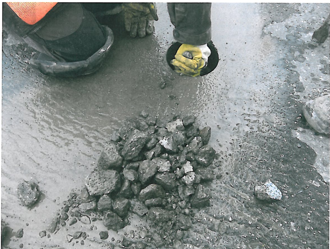
Fot . 12. Pobieranie próbki kruszywa z podbudowy, odkrywki Nr 7 w km 1+625
