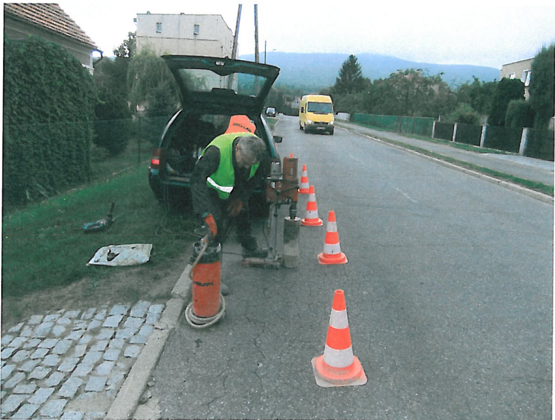
Fot . 10. Lokalizacja odkrywki Nr 8 w km 1+875, pas lewy
