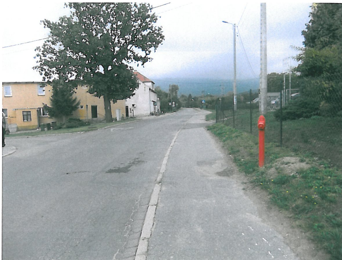
Fot . 15. Widok odcinka ul. M. C. Skłodowskiej, km 1+400.
