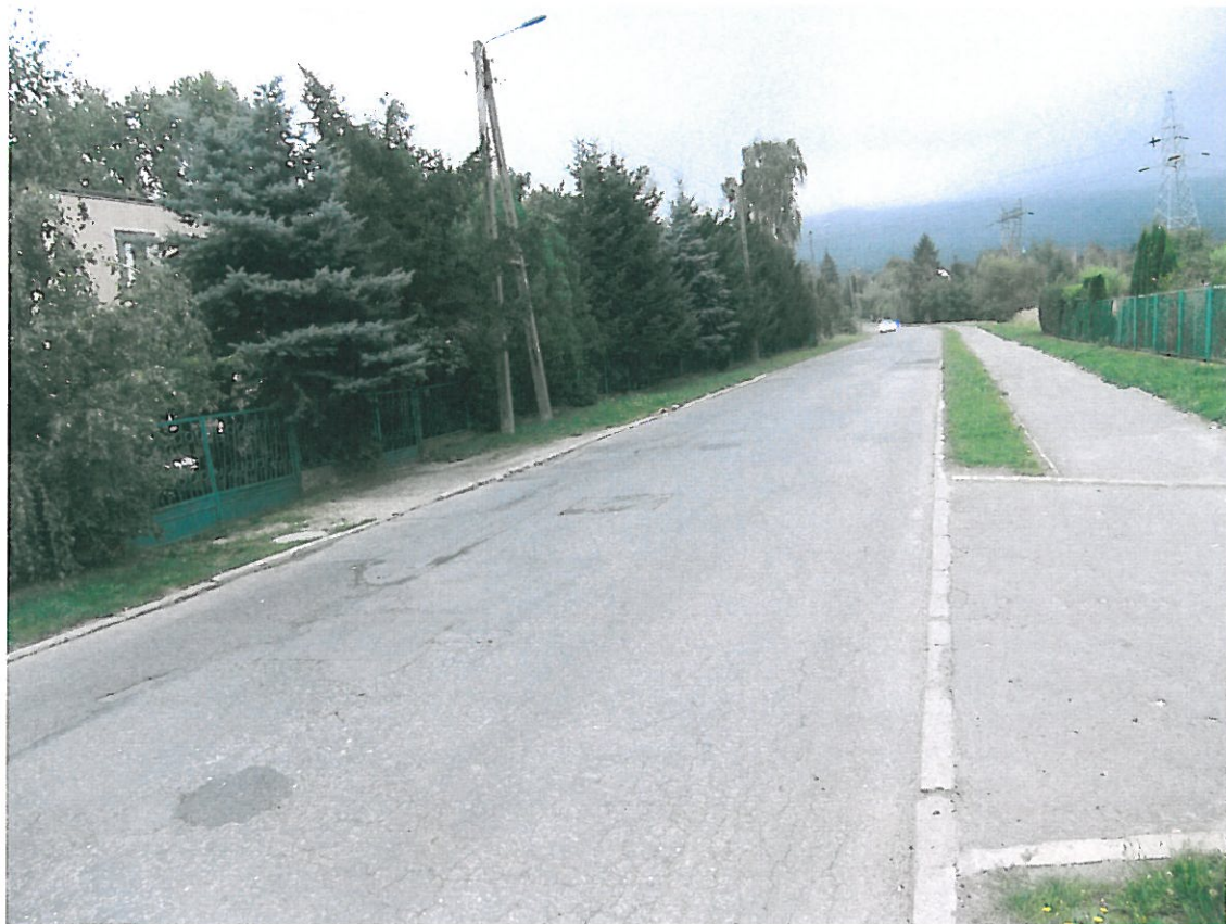
Fot . 16. Widok odcinka ul. M. C. Skłodowskiej, km 1+500.
