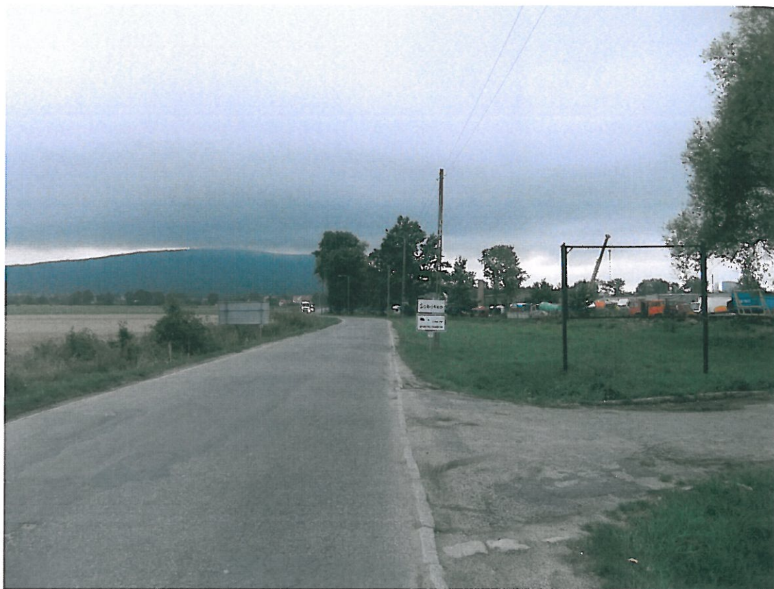
Fot . 1. Widok odcinka ul. R. Zmorskiego ( km 0+000).
