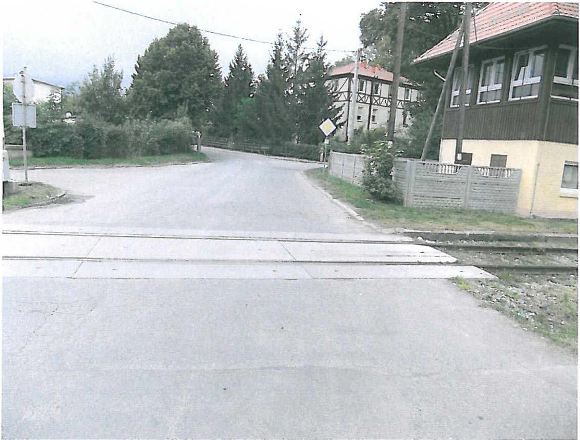
Fot . 7. Widok przejazdu kolejowego w km około 0+600.
