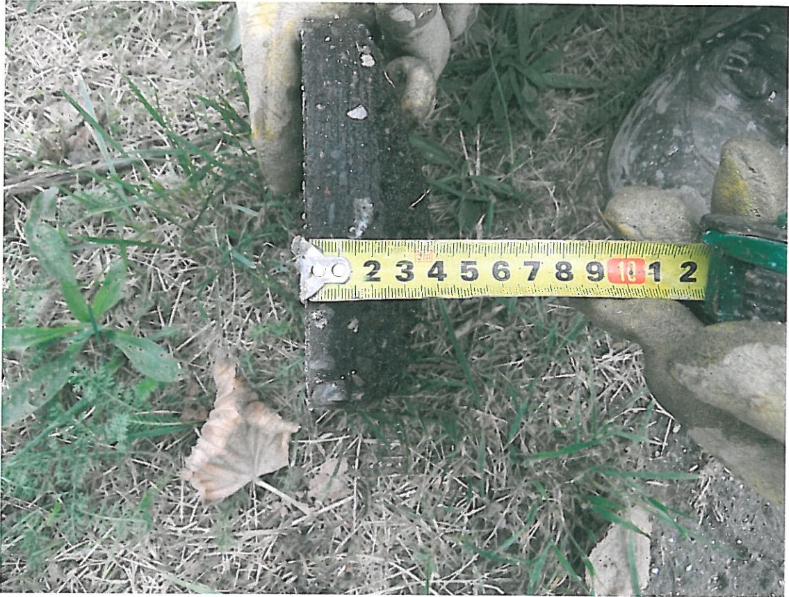
Fot . 12. Widok odwiertu warstw bitumicznych z odkrywki Nr 4 w km 0+875
