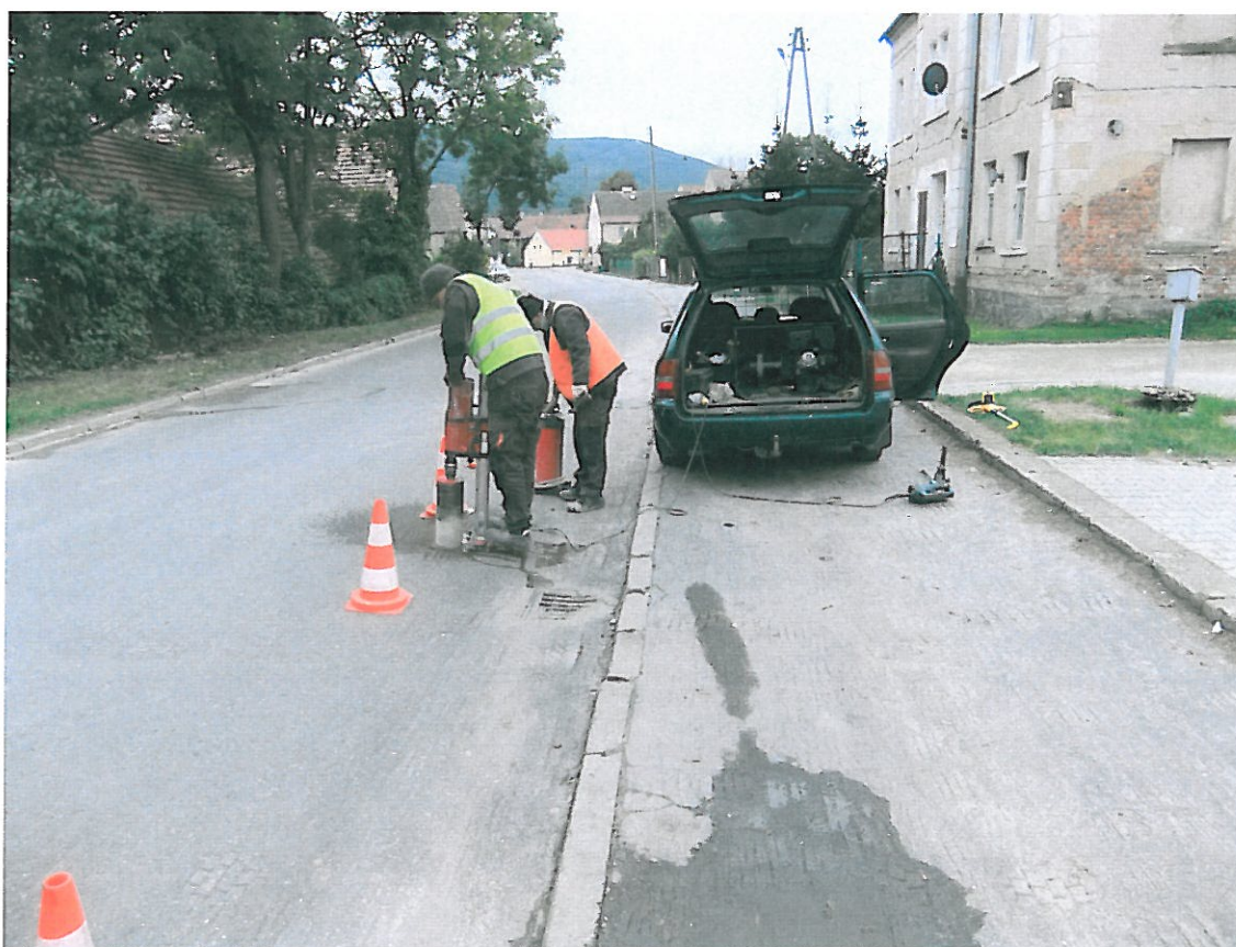
Fot . 10. Lokalizacja odkrywki Nr 5 w km 1+105, pas prawy
