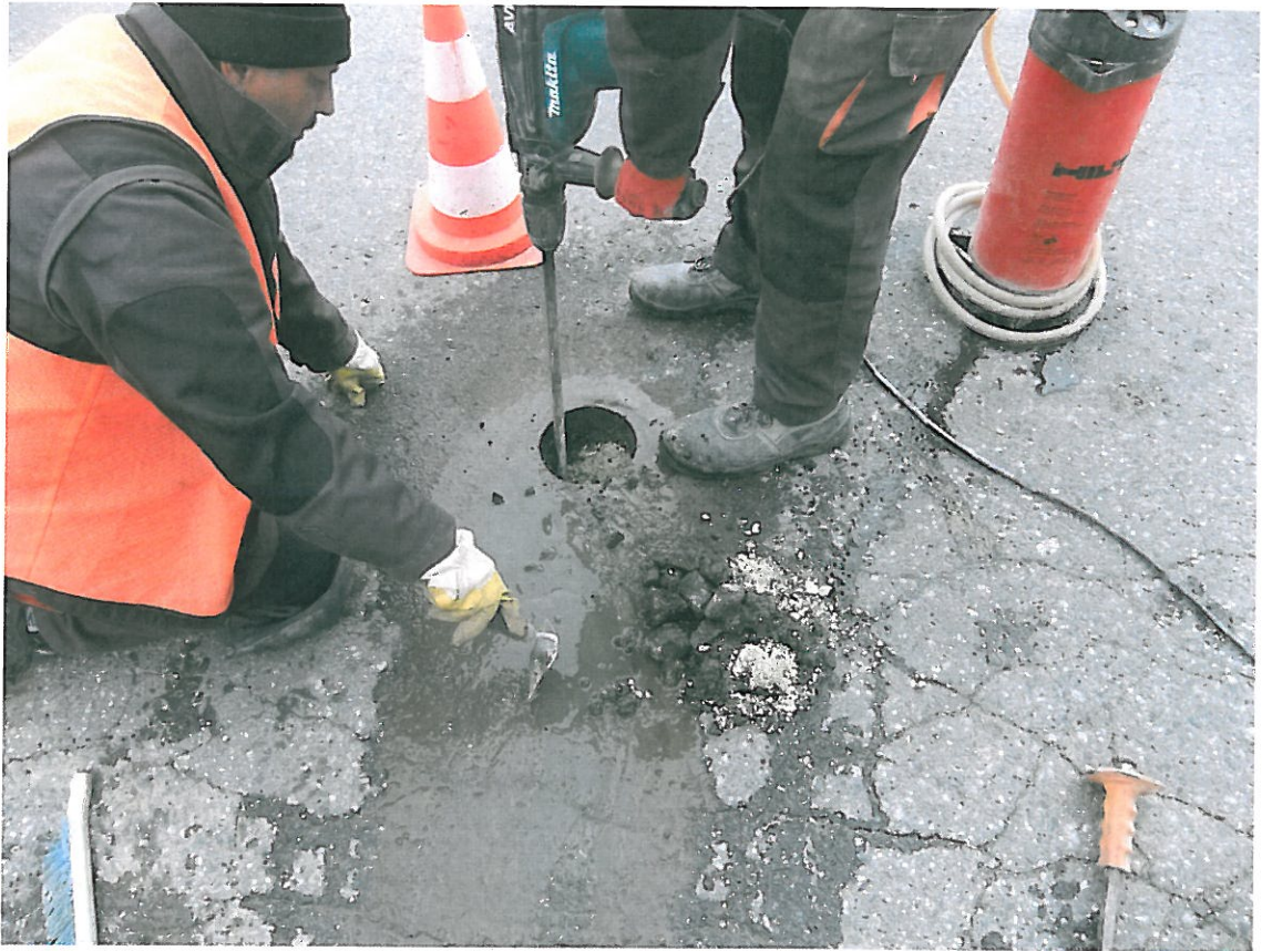
Fot . 12. Pobieranie próbki z podbudowy odkrywki Nr 1 w km 0+125
