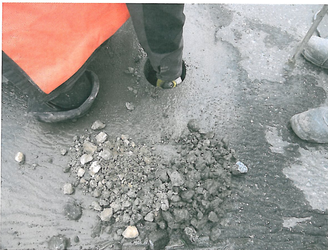
Fot . 12. Pobieranie próbki kruszywa z podbudowy, odkrywki Nr 7 w km 1+625
