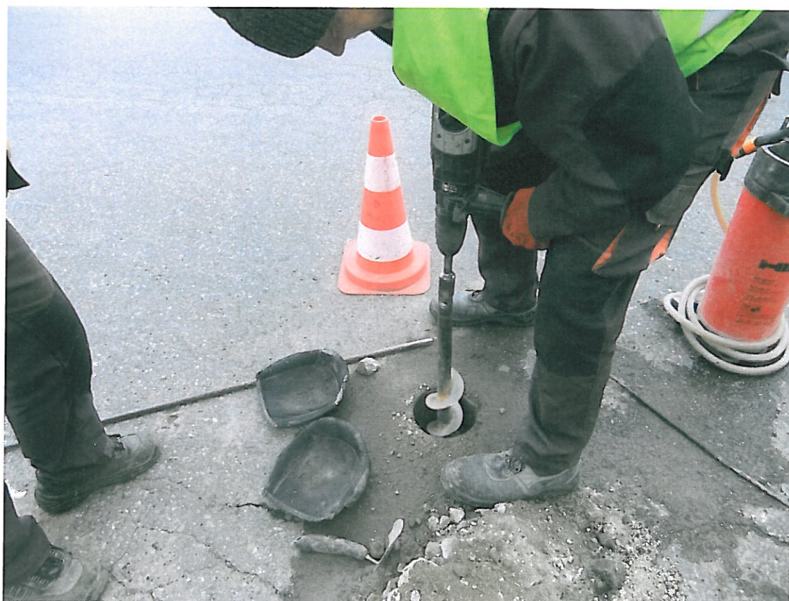
Fot . 13. Widok odkrywki Nr 1 w km 0+125, pobieranie próbki pospółki.
