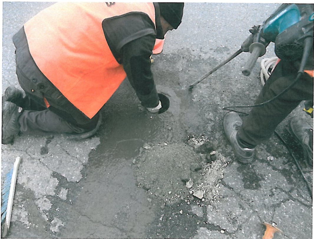
Fot . 11. Widok próbki kruszywa 0/8mm z odwiertu Nr 1 w km 0+125, pas prawy
