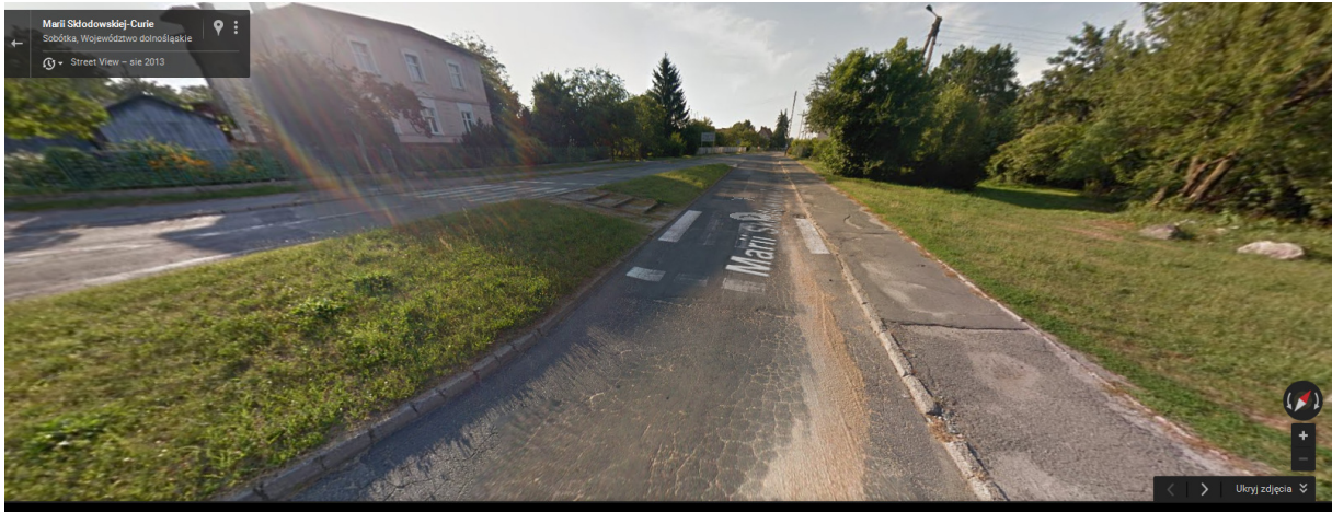
Fot. 1 Ul. M.C. Skłodowskiej – odcinek przy skrzyżowaniu z ul. Świdnicką
