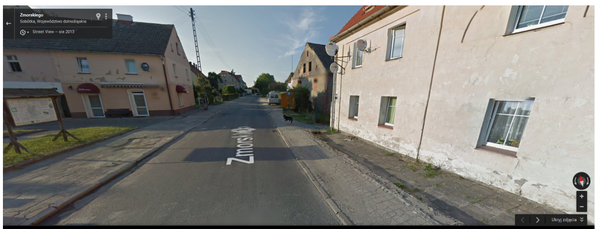
Fot. 6 Ul. R. Zmorskiego – odcinek na wysokości budynku nr 1
