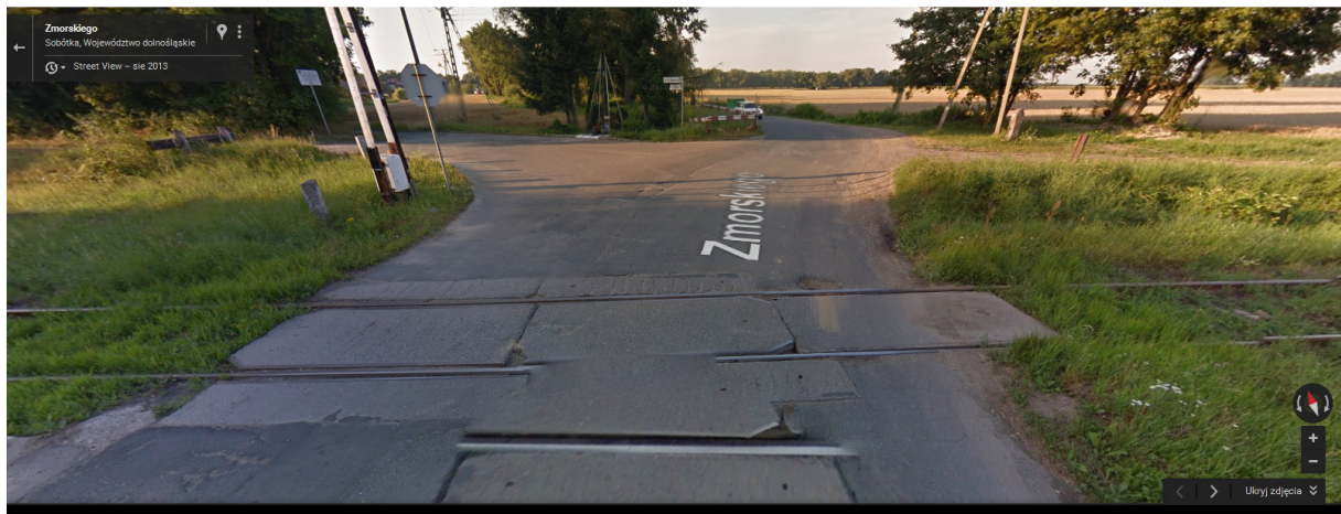
Fot. 8 Ul. R. Zmorskiego – przejazd kolejowy
