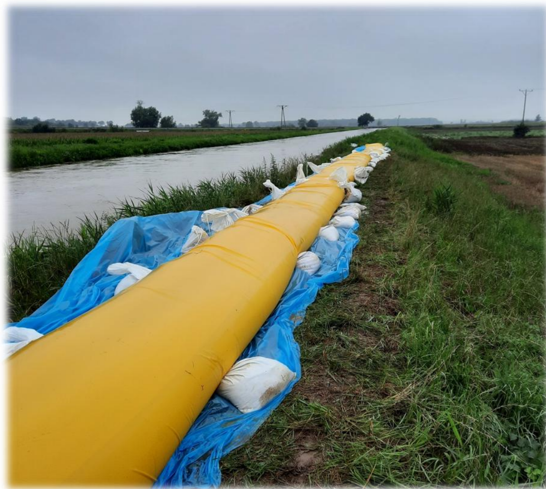
Fot. 4: Wał przeciwpowodziowy pomiędzy Sobótką a Rogowem Sobóckim.
