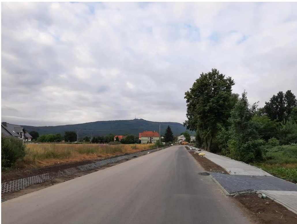
Rysunek 4 Remont ul. R. Zmorskiego – etap III
