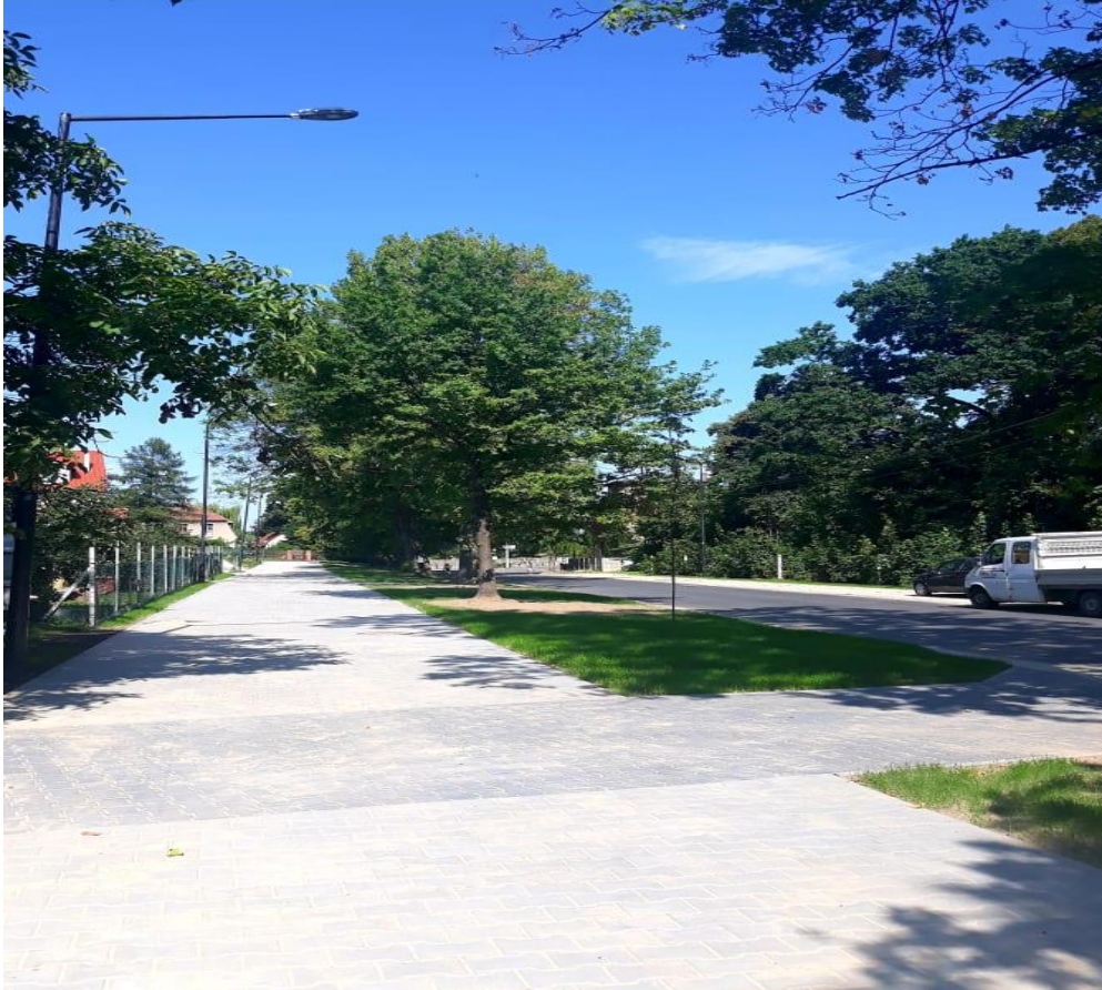
Rysunek 3 Remont ul Dworcowej i ul. Stacyjnej w miejscowości Sobótka
