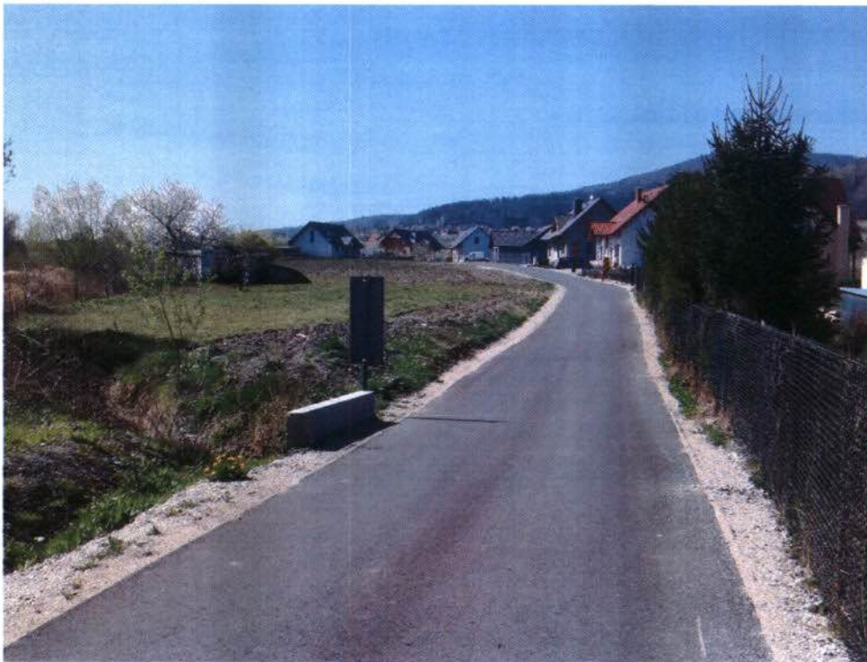
Rysunek 3 Modernizacja drogi ul. św. Norberta w Strzegomianach
