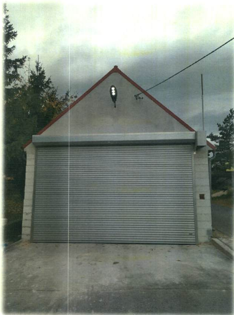
Fot.: Remiza ochotniczej Straży Pożarnej w Sobótce Zachodniej
