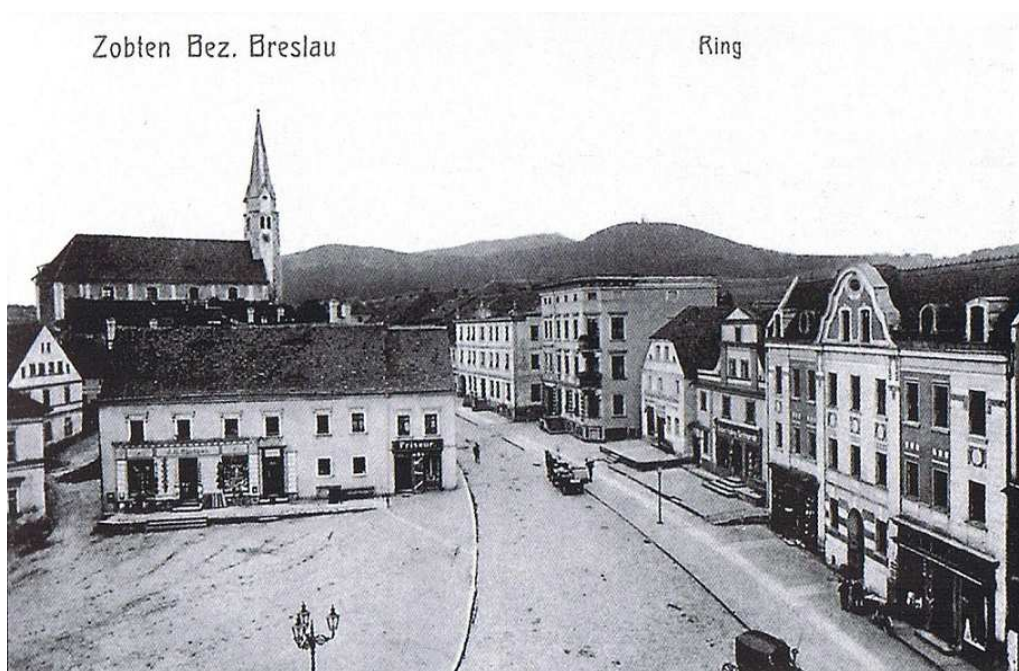
Ryc. 1. Widok na plac oraz ul. Św. Jakuba
