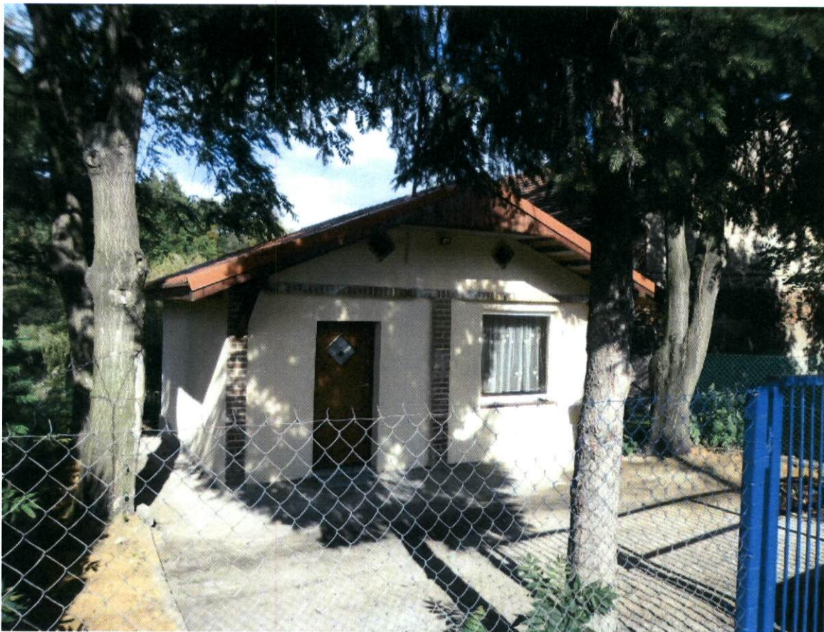
Remiza po remoncie (służy jako świetlica)
