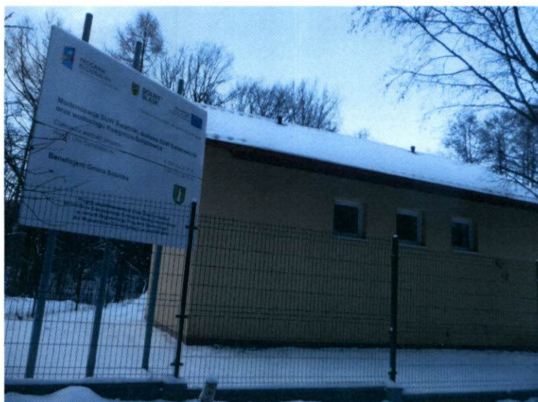
Rysunek 15 Budynek stacji uzdatniania wody w Sulistrowiczkach
