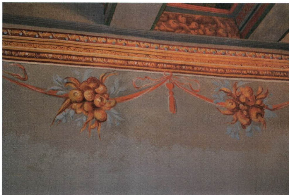
Rysunek 10 Dekoracyjne element zdobnicze na ścianach i na suficie, w trakcie prac konserwatorskich (październik 2016r.)
